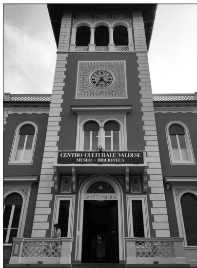
L’edificio che ospita la Fondazione appena restaurato (ottobre 2016)
